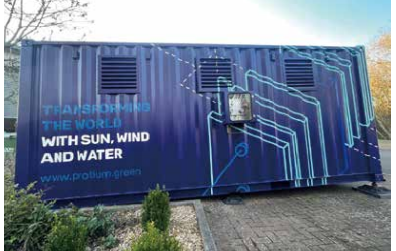
燃料電池用100kWコンテナ
